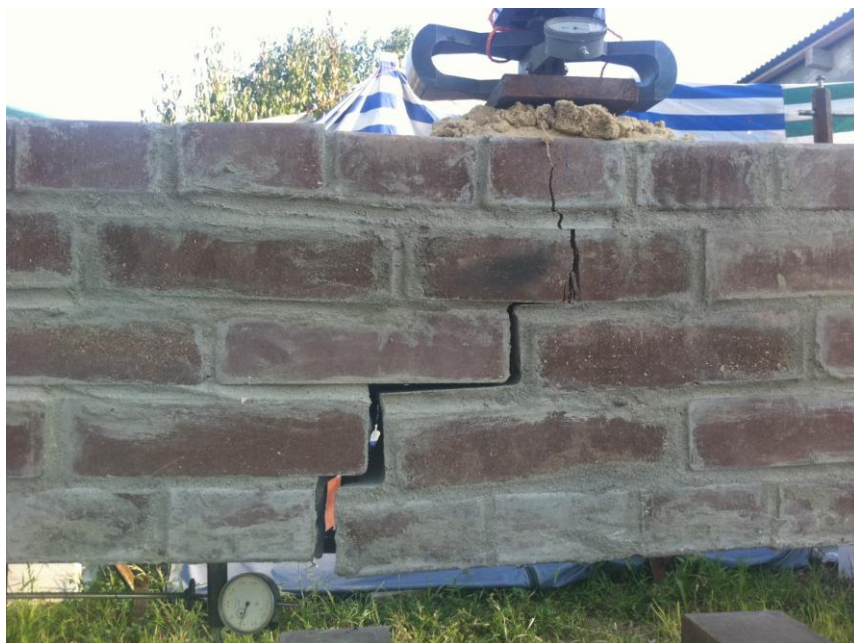
Рис. 9. Общий вид балки перед разрушением
