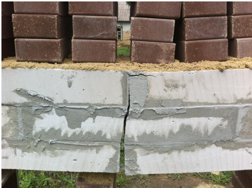
Рис. 6. Образование продольной трещины в сжатой зоне перемычки
