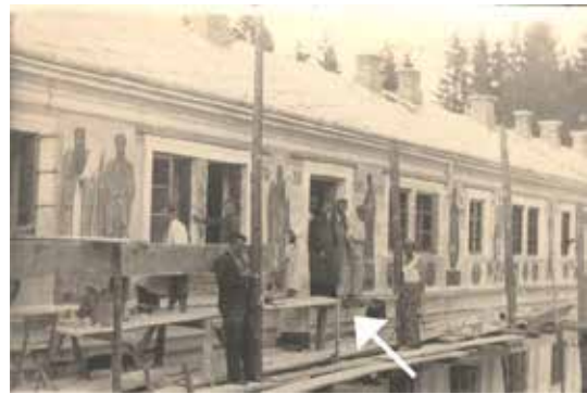
Рис. 2. Оздоблення стінописами зовнішніх стін (приблизно 1935–1937)
