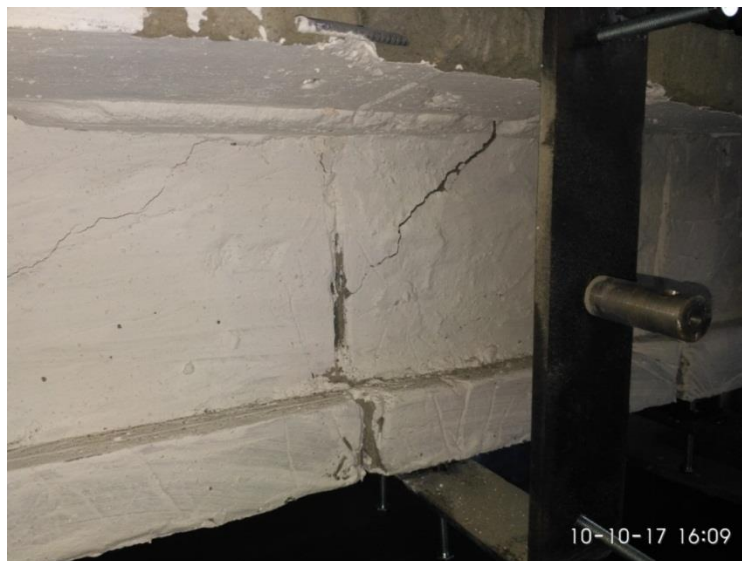
Рис. 6. Похила тріщина від вершини штучної нормальної тріщини у балці
