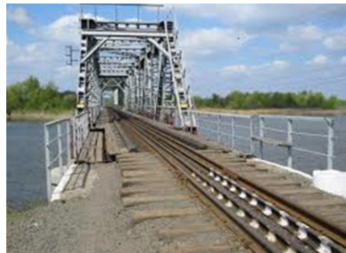
Рис. 4. Залізничний міст через р. Південний Буг поблизу м. Гайворон
